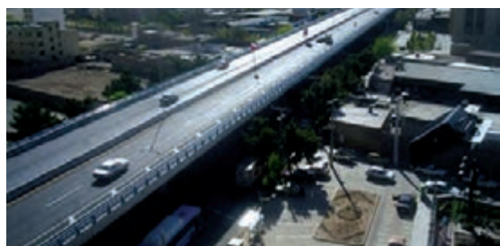
پل روگذر آزادراه از جنس فولاد آلیاژی
